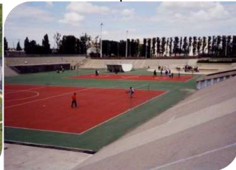
Bassin de rétention © CG93, 1999
