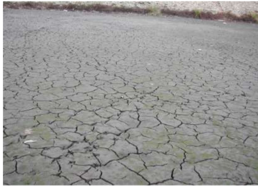
Bassin d'infiltration © L.S.E - ENTPE
