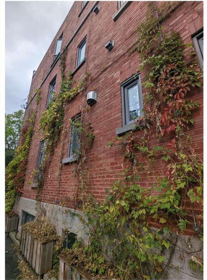
Façade végétalisée - particulier Montréal 2019
