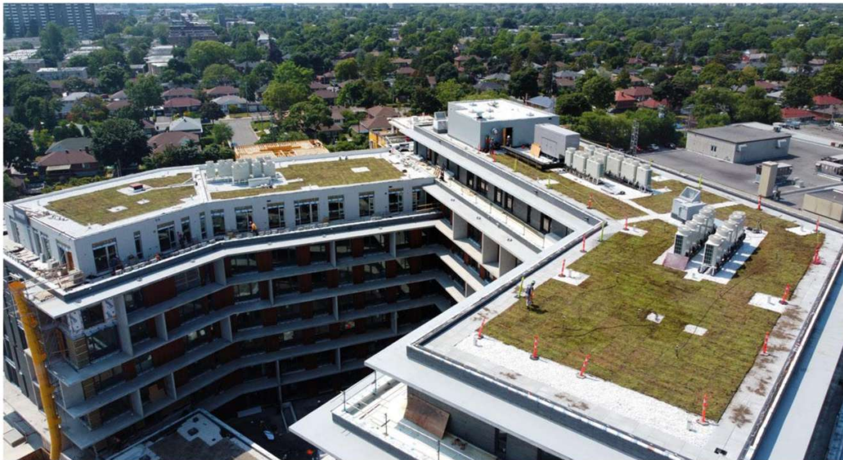
Toiture végétalisée extensive Tapis de Sedum - Midtown 2021
