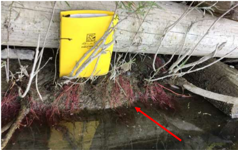
CROISSANCE DES RACINES À TRAVERS LES INSTALLATIONS
