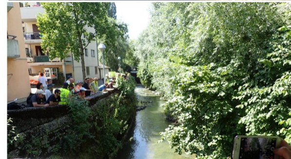
Protection de berge avec un caisson végétalisé sur l'Albanne à Chambéry (en 2011 en haut, gros plan en 2016 en bas)
