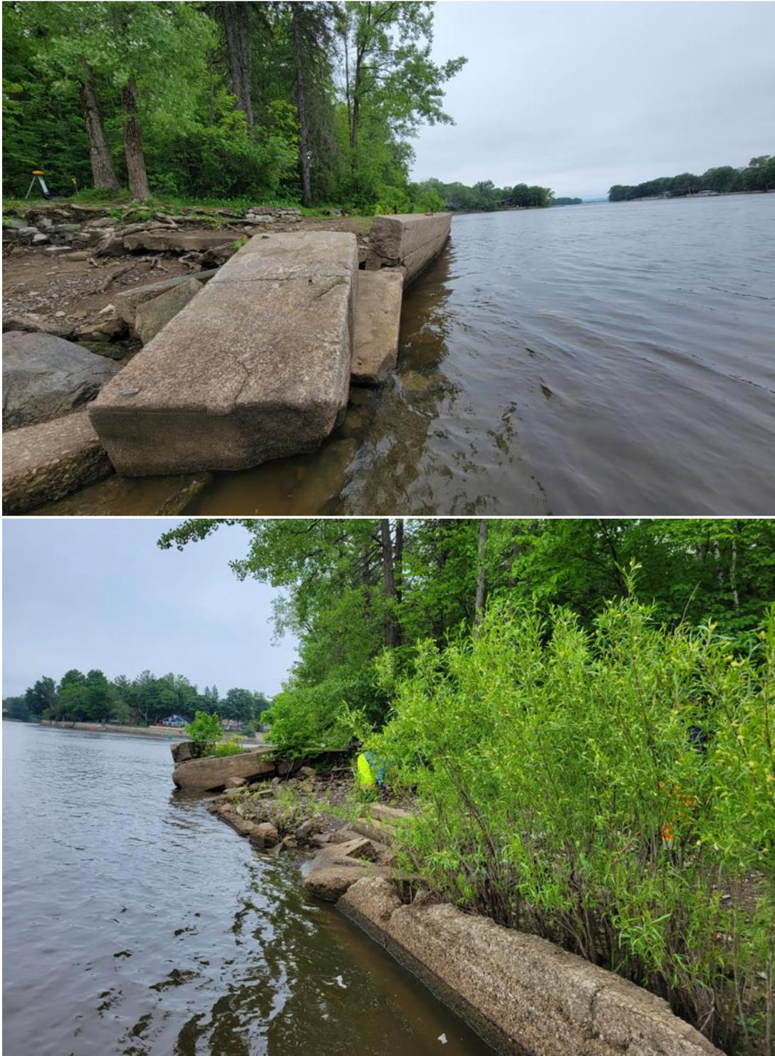
**Figure 32** Mur de béton dégradé présent au tronçon 1176 du parc de l'Île-Bizard. La photo du bas montre la rangée de *Salix interior* derrière une section du mur.
