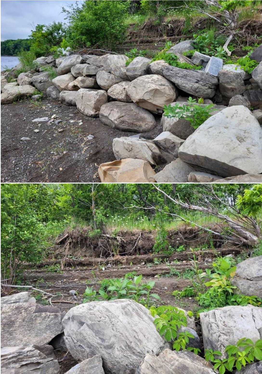
**Figure 34** Tronçon 1136 avec vue de l'empierrement existant et du haut de talus érodé, dans le parc du Bois-de-Liesse.
