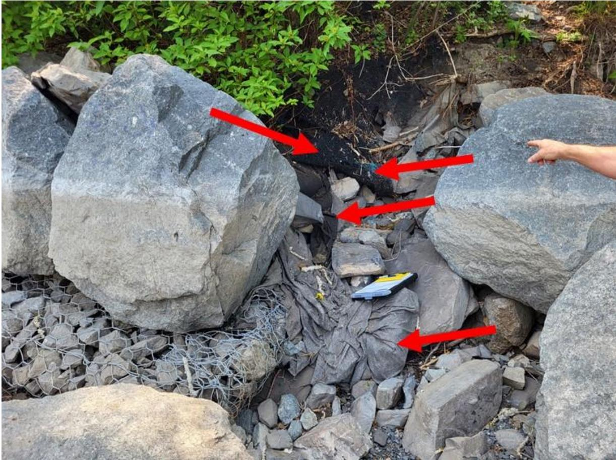
**Figure 37** Présence de quatre géotextiles de plastique différents au parc Promenade-Bellerive.
