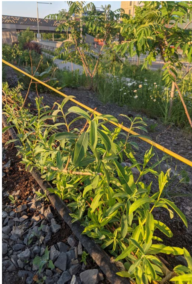
Figure 26 — L'irrigation avec un système de tuyau suintant est parfois utilisée pour favoriser l'enracinement des végétaux dans les premières années d'un ouvrage de stabilisation de pente.
