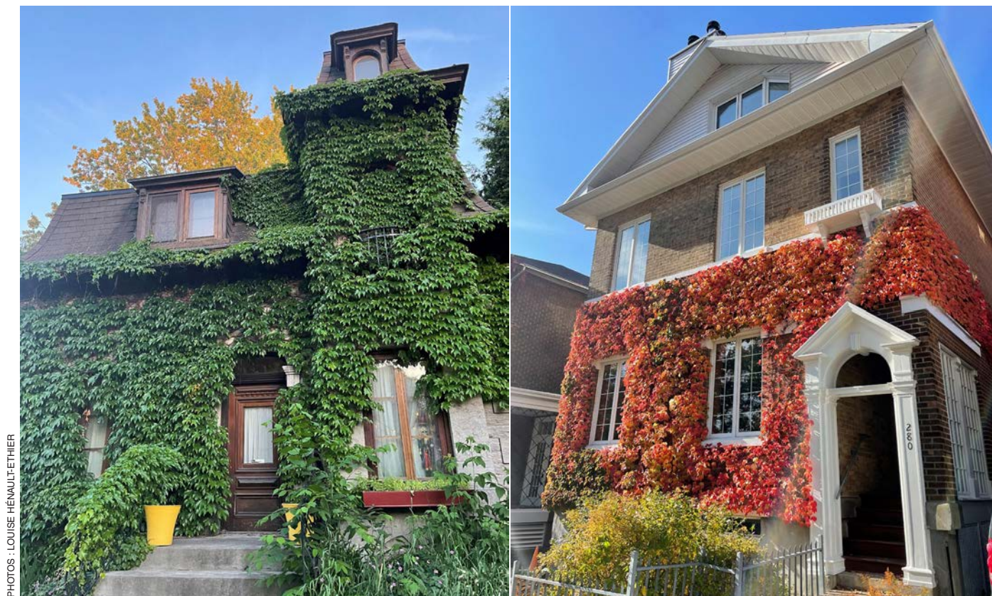
Figure 14 – Les murs grimpants doivent être taillés périodiquement notamment pour empêcher la pénétration de la végétation dans l'entretoit.
