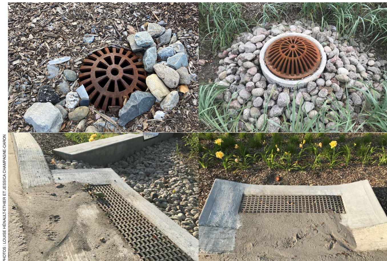
Figure 17 – L'entretien des biorétentions implique le nettoyage des grilles d'égout de même que celles des caniveaux de sédimentation empêchant le colmatage du substrat.
