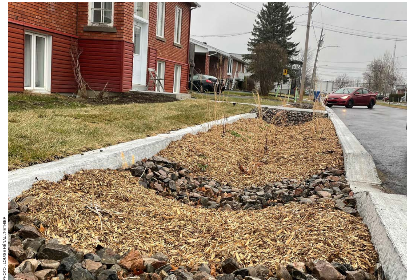
Figure 1 — Bien que les aires de fort débit aient avantage à être en enrochement, le paillis s'avère utile en zone d'infiltration pour limiter la croissance des adventices.
