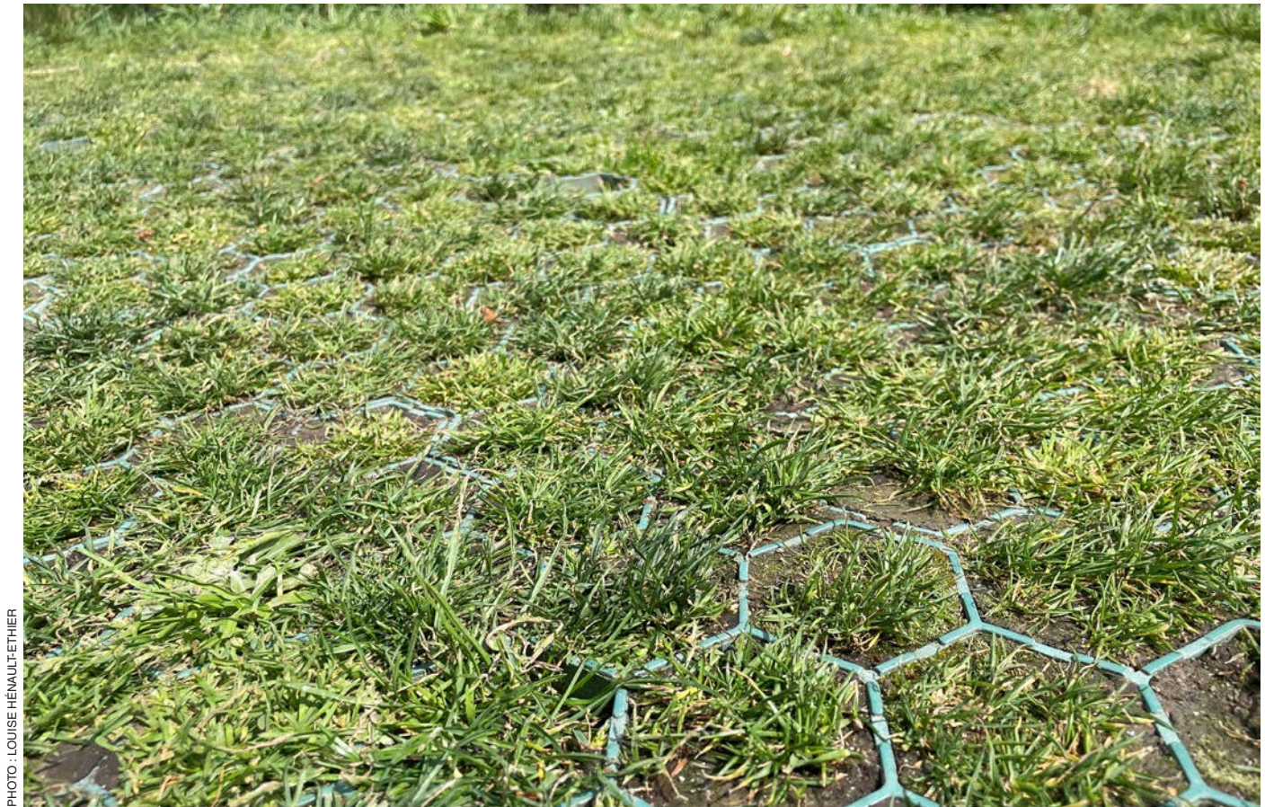
Figure 6 — L'entretien de la végétation dans les gazons renforcés implique une tonte qui n'affecte pas les matériaux structurants ou les sursemis dans les cellules du tapis moins fournies.
