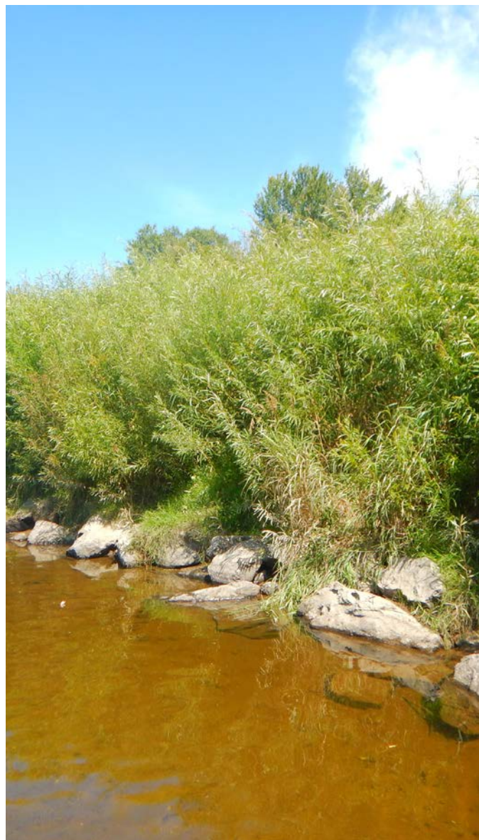
Figure 25 — Les saules arbustifs sont souvent utilisés dans les ouvrages de stabilisation de berges. Ici, des matelas de branches de Salix interior sont implantés avec un enrochement de pied de berge.
