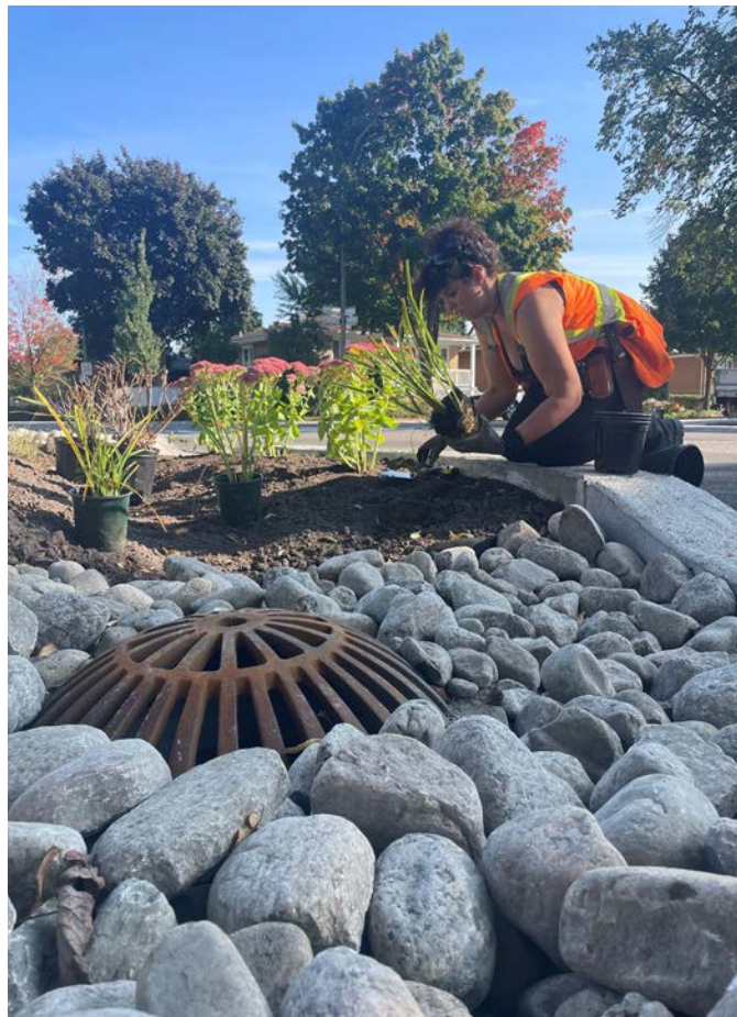
Figure 15 — Plantation de végétaux dans une nouvelle biorétention aménagée en bordure de rue.
