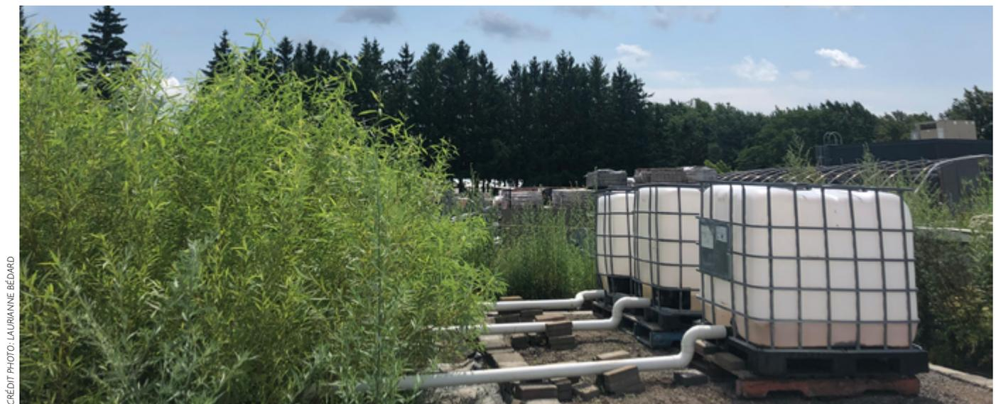
**Figure 4** – Citernes de 1000 L pour le stockage des eaux usées traitées par un marais filtrant à effluent nul, au Jardin botanique de Montréal.
