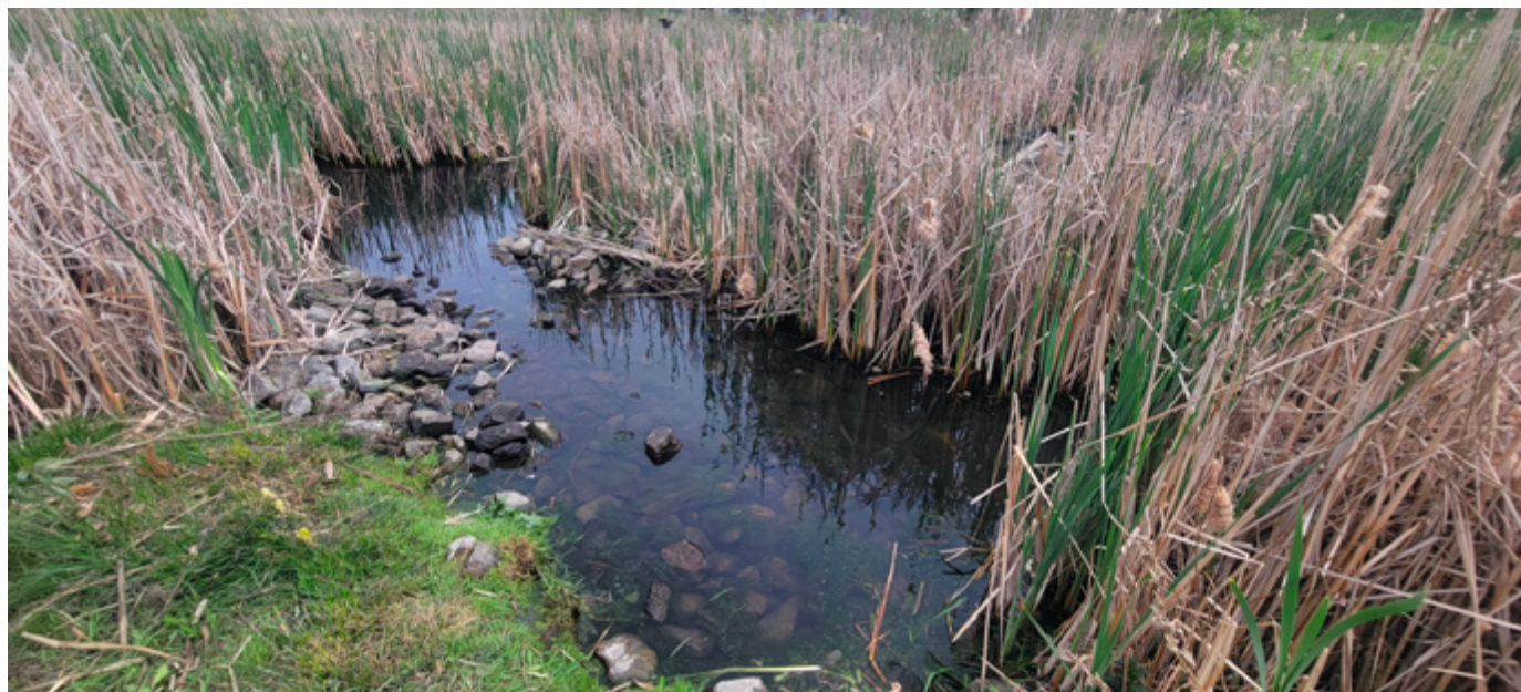
Figure 17 – Graviers grossiers utilisés comme substrat dans un marais filtrant surfacique.
