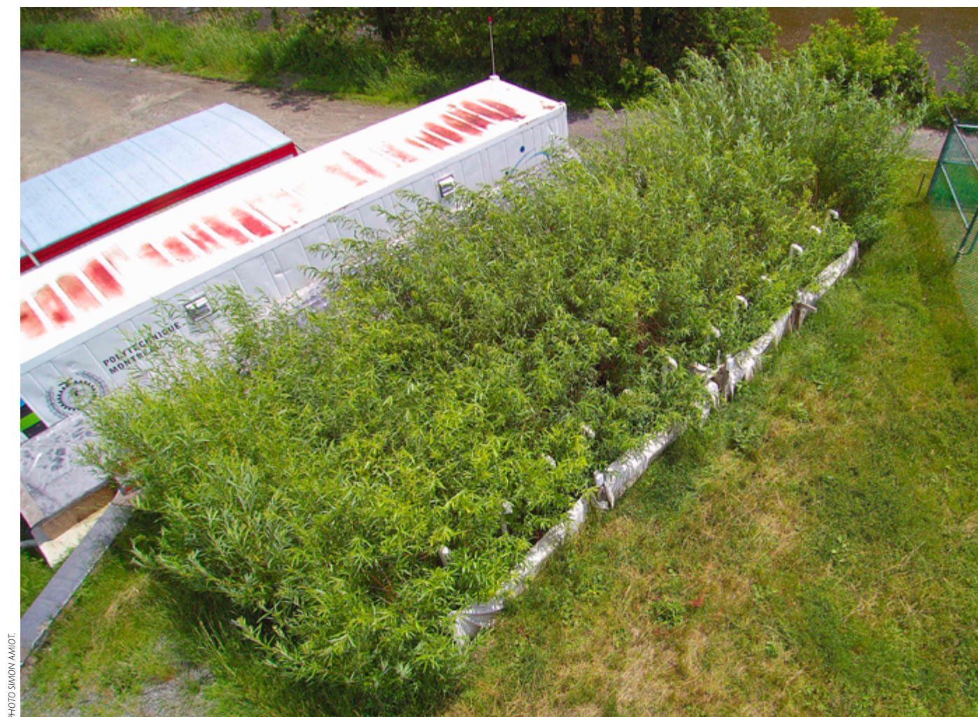
Figure 20 — Prototype de marais filtrant sous-surfacique à flux vertical pour le traitement des eaux usées municipales au Québec.
