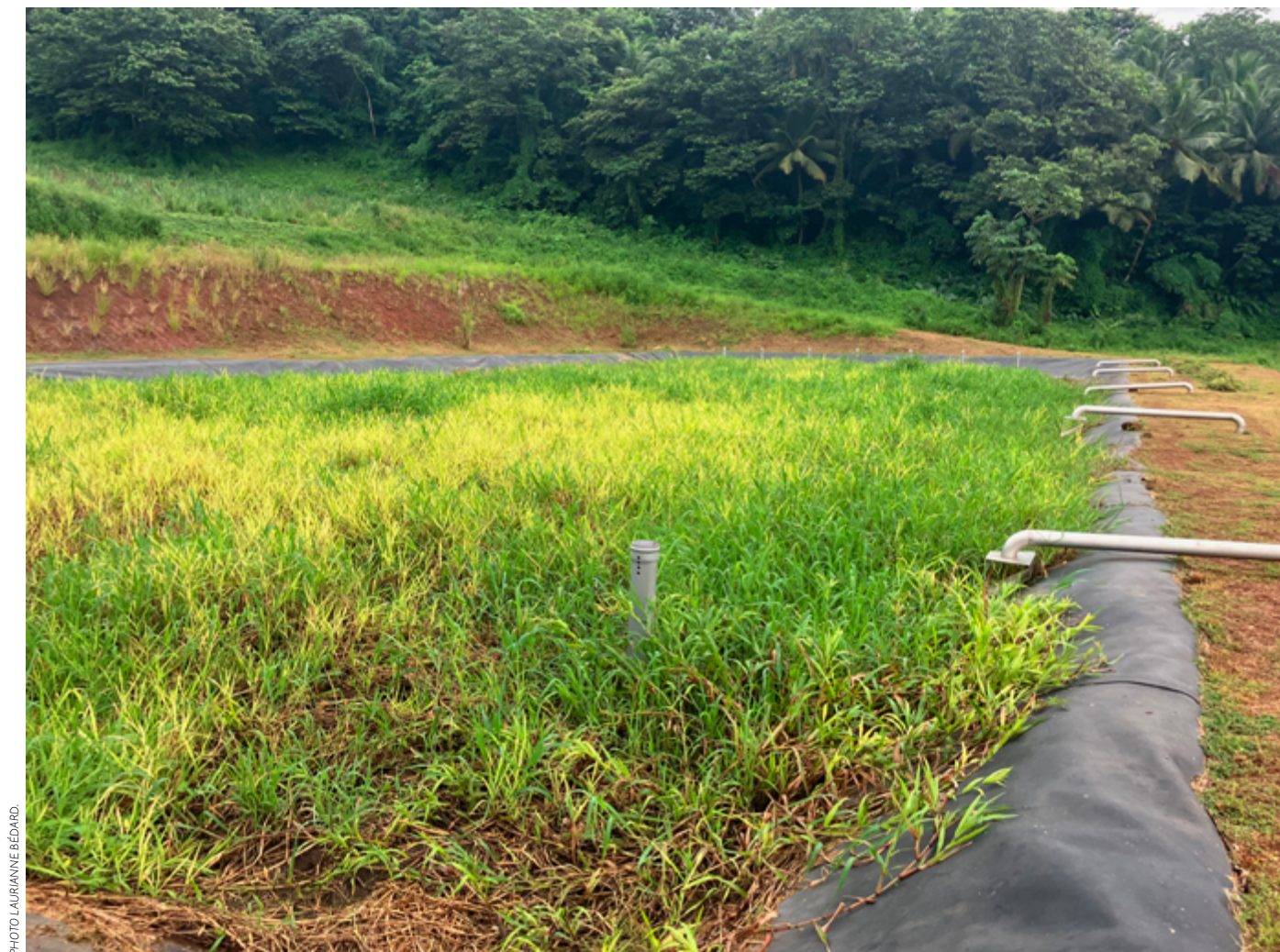
Figure 21 — Marais filtrant sous-surfacique à flux vertical pour le traitement des eaux usées en Martinique.
