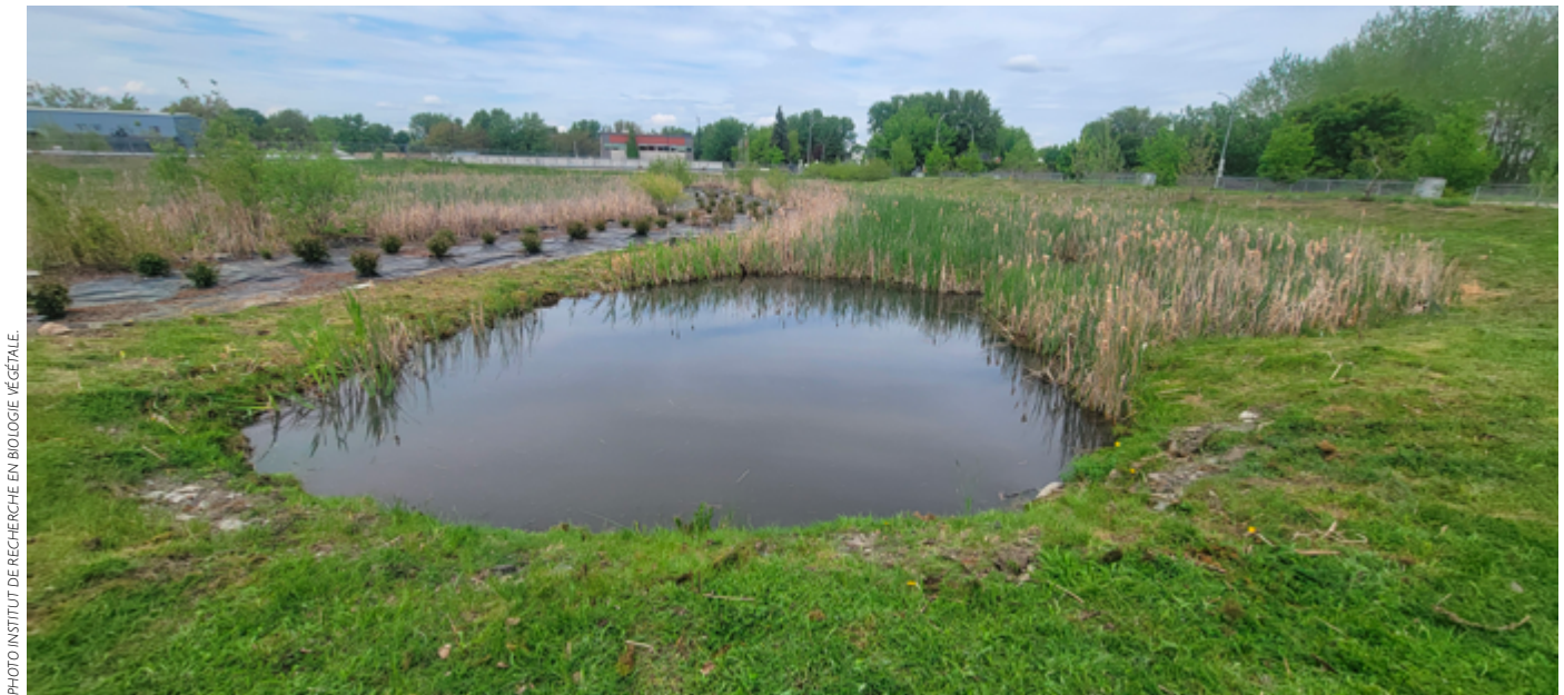
Figure 16 — Bassin filtrant traitant les eaux des nappes phréatiques à Montréal-Est.
